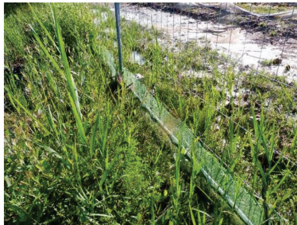
Photo 34: Barrière à amphibiens en doublement d'une barrière de chantier de type Heras
